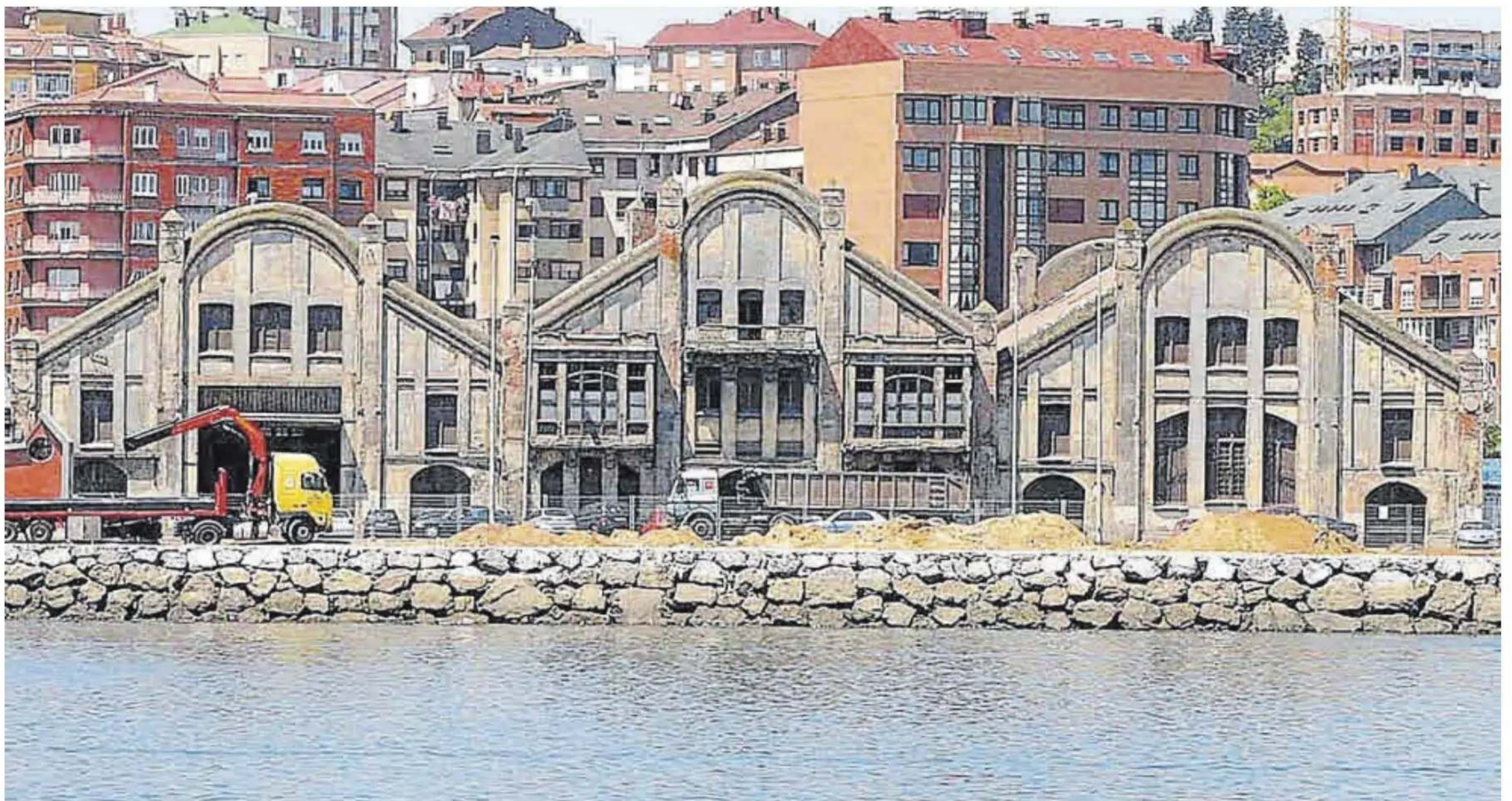
Naves vistas desde la margen derecha durante las obras de remodelación del paseo de la ría.
